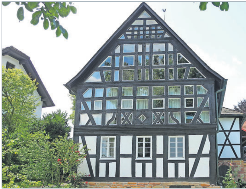
Das alte Schulhaus in Wippenbach.
